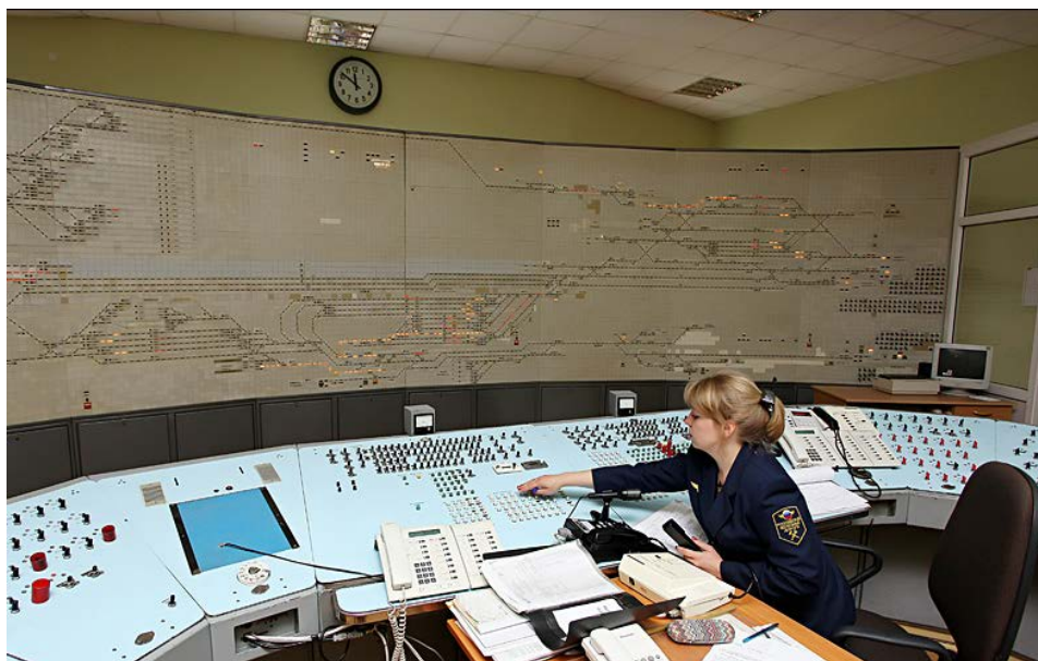
Фото 1 – Электромеханический пульт управления ДСП: пульт – манипулятор с кнопками и рукоятками управления и выносное табло с мнемо-схемой железнодорожной станции
