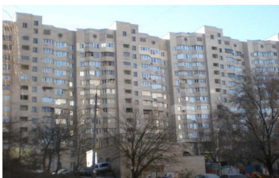
Рис.1 Главный северный фасад дома 1
