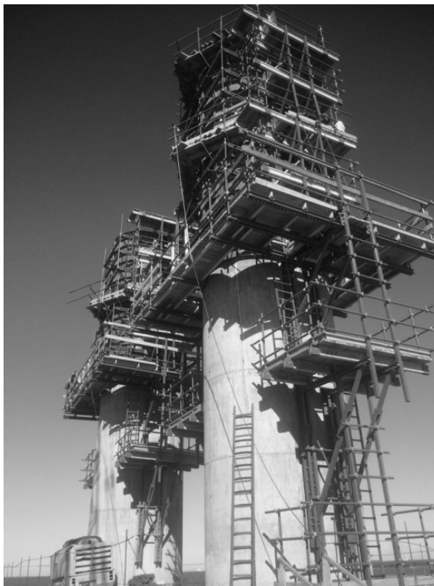
Рис. 4 – Установка второго комплекта щитов опалубки поверх первого
