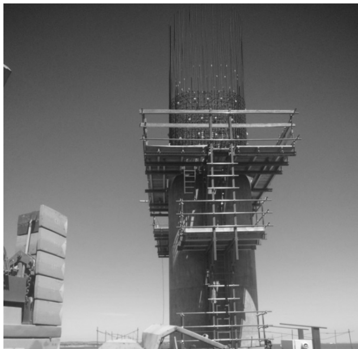
Рис.2 – Стыковка каркасов стоек с применением самоподъемной опалубки
