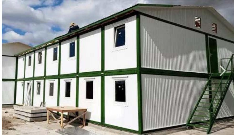
Рисунок 2. Модульное здание из блок-контейнеров
