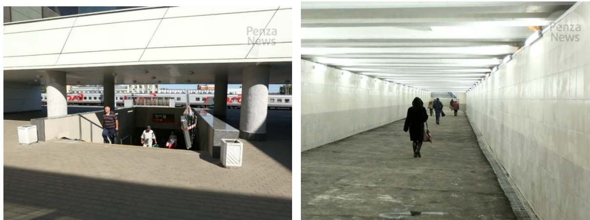
Рис. 5 – Подземный пешеходный переход на Пензе-1
