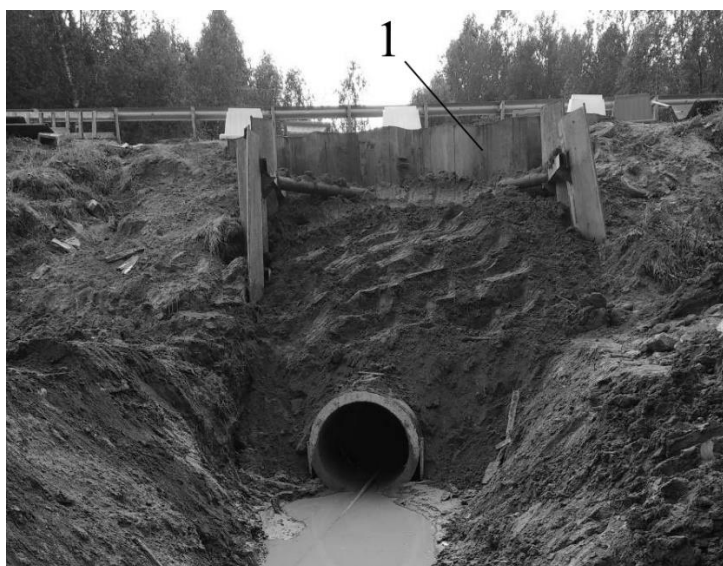
Рис. 3 – Разбор насыпи (1 – шпунтовая стенка)
