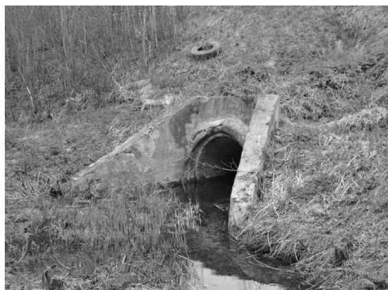
Рис. 1 - общий вид водопропускной трубы
