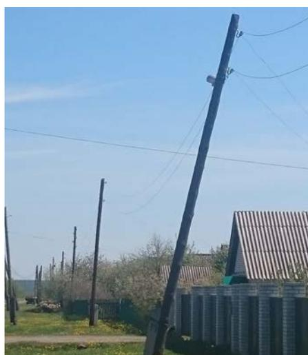
Рис.1. Отклонение от центральной оси
