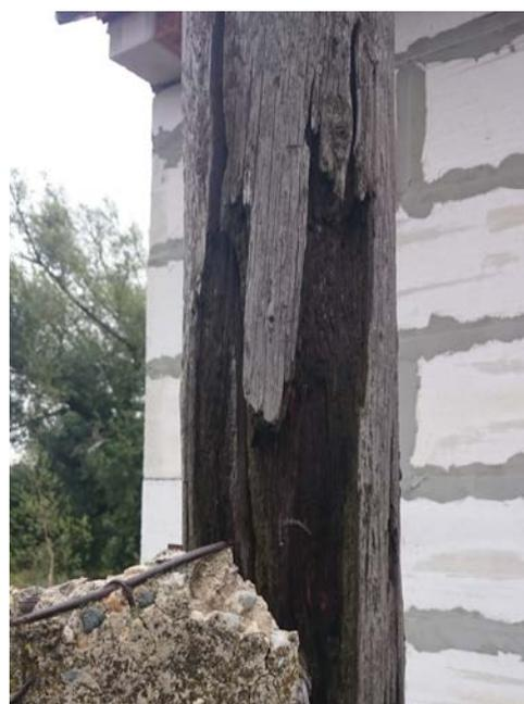
Рис.4. Частичное разрушение основания
