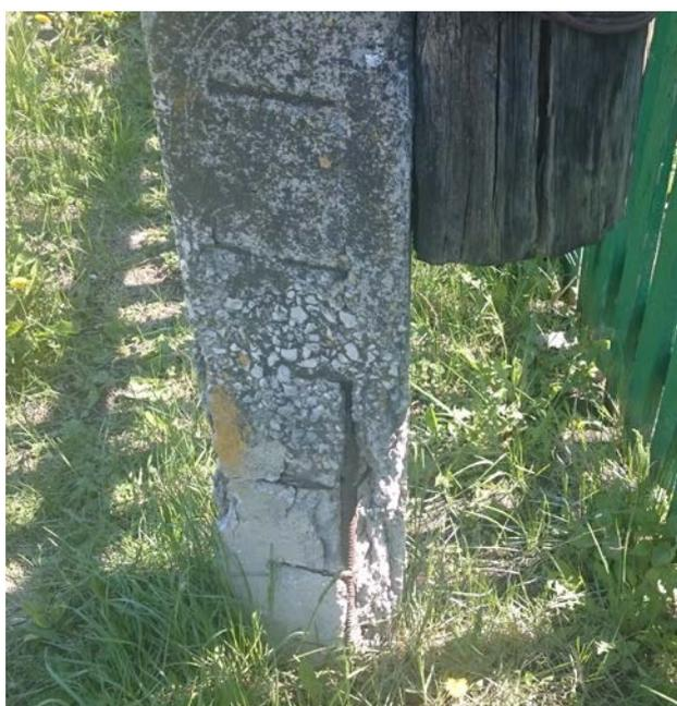
Рис.3. Частичное разрушение основания
