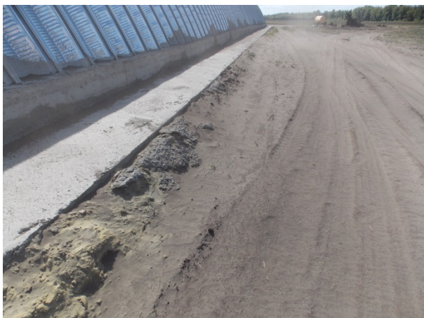
Рис.3 Планировка грунта находится на 700 мм выше отмостки (Пензенская область, Лопатинский район)
