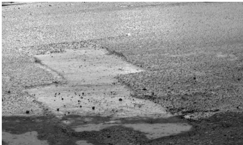
Рис. 5 – Образование осадки после остывания литой смеси. Наглядно показана разница содержания битума и каменного материала в асфальтобетоне полотна и смеси
