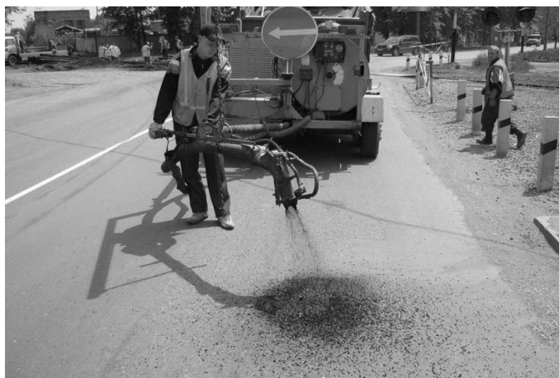
Рис. 4 – Выполнение ремонта методом пневмонабрызга
