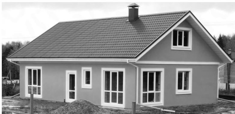
Рис. 2 – Применение СФТК в малоэтажном строительстве в г. Кирове
