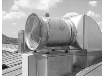
Рисунок 5. Крышной осевой вентилятор приточной противодымной вентиляции без конфузора.
